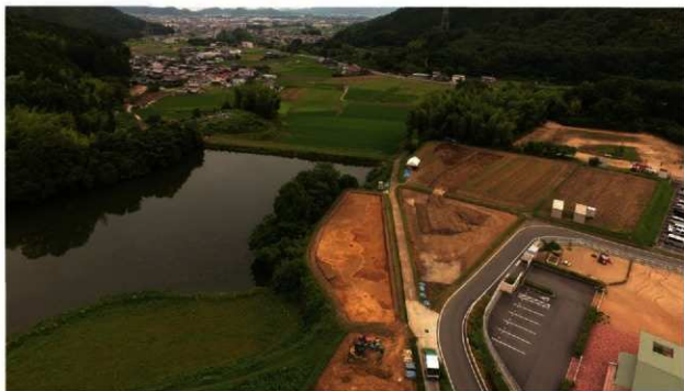
1区空中写真（北上空から）
