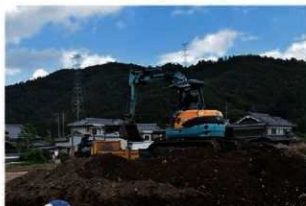
南半機械掘削
