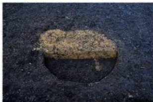
SX25 断面 (東から)
