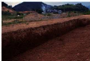
D区堆積状況
