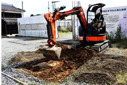
1G 機械掘削
