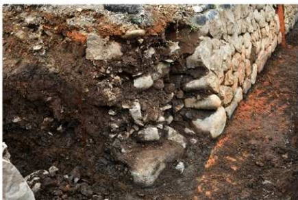
石垣南トレンチ裏込め状況
