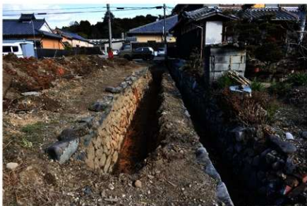
石垣検出状況（南から）
