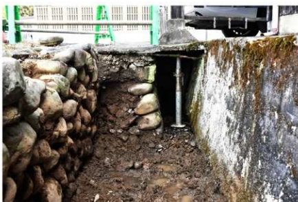
石垣北側クランク部分
