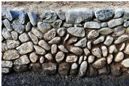
石垣積み直し変換地点（東から）
