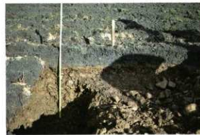
No.40 断ち割り
