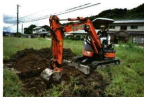
No.51 機械掘削
