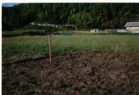
No.75 埋戻し終了 (南から)
