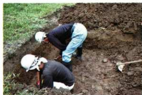
No.57 人力掘削
