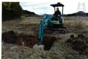
No.1-1 機械掘削
