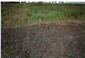
No.14 埋戻し終了 (南から)
