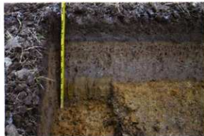
No.71 断ち割り
