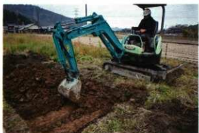
No.77 機械掘削
