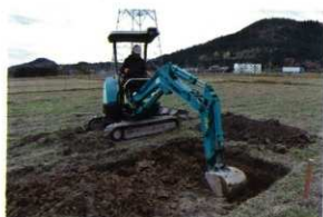
No.7 機械掘削
