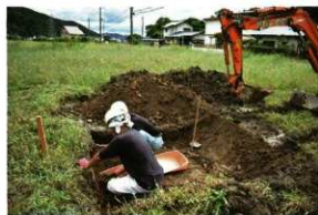
No.51 人力掘削
