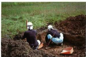
No.52 人力掘削
