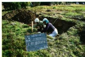
No.27 人力掘削
