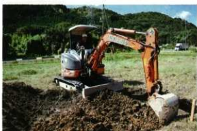
No.13 機械掘削
