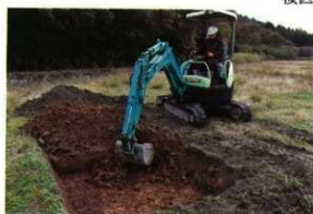
No.1 機械掘削
