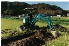
No.22 機械掘削
