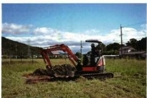
No.53 機械掘削
