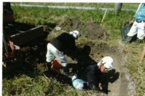
No.100 人力掘削
