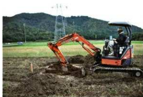
No.81 機械掘削
