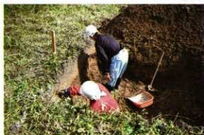
No.86 人力掘削
