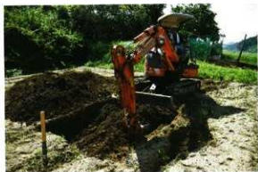
No.95 機械掘削
