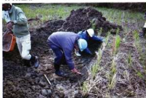
No.70 人力掘削
