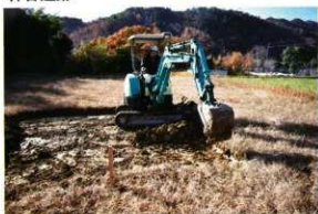
No.62 機械掘削
