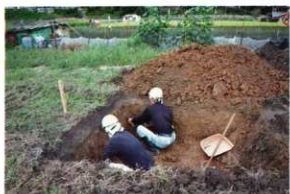
No.76 人力掘削
