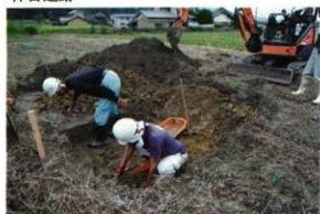
No.74 人力掘削
