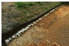
暗渠 (南西から)
