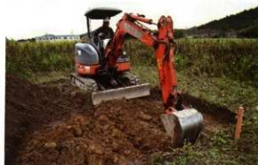
No.90 機械掘削
