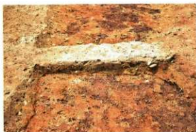
SX04 断面 (南から)
