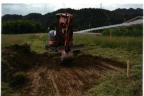
No.67 機械掘削
