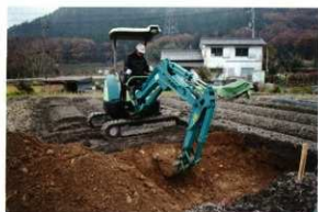
No.32 機械掘削
