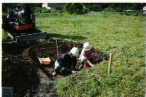
No.44 人力掘削
