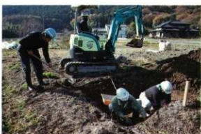
No.24 人力掘削
