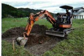
No.60 機械掘削
