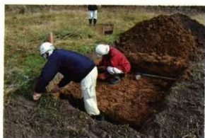
No.1 人力掘削
