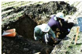
No.21 人力掘削
