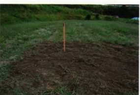
No.68 埋戻し終了 (南から)
