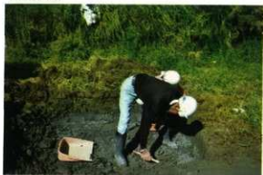
No.96 人力掘削
