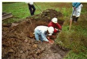
No.91 人力掘削
