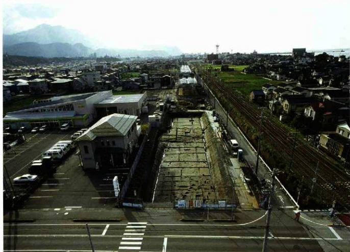
3区近景 (東から)
