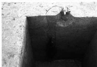
杭 76 (904) 断面 (北から)
