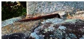
図3 錠とモルタルによる部材の接合
