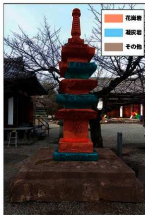
図4 各部材ごとの石材の分類(南面)
