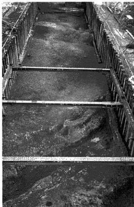
Eトレンチ全景（北から）
