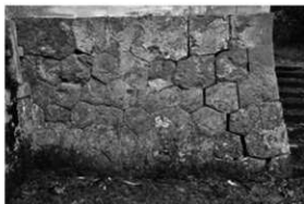
写真5 城上神社本殿の石垣
