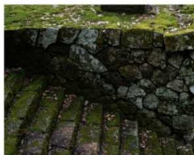
写真20 定徳寺山門下の階段と北側石垣
