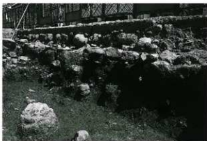
北側壁面（南東方向から）
