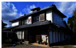
主屋南面外観
