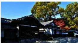
「新玄閣」棟(手前)と「大広間」棟
