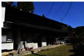
主屋南面外観
