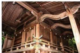
本殿軒見上げ
