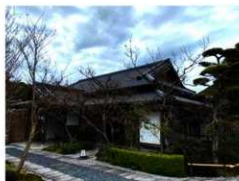
主屋 南東面外観
