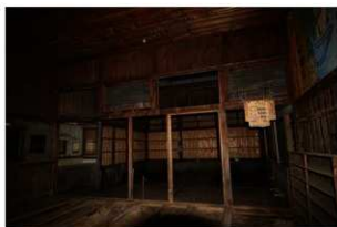
脱衣場から浴場を望む
