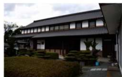
主屋東面外観
