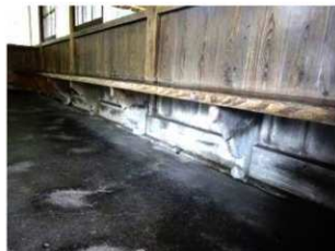
待合室ベンチの持ち送り
