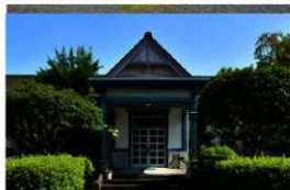
正面玄関ポーチ
