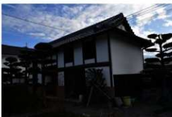
長屋門北面外観
