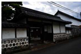
長屋門正面(西面)外観
