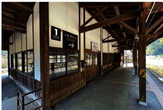
JR 肥薩線白石駅舎 [54] 芦北町
