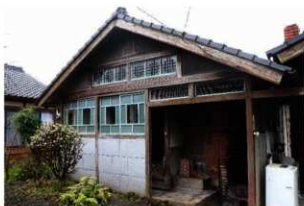
漬物小屋・風呂場 北面外観
