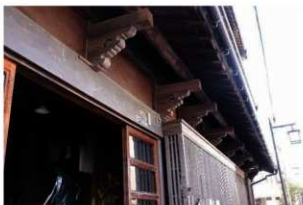
土間へ続く脇門、出格子、腕木を受ける持送り
