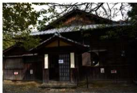
玄関廻り外観
