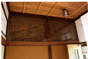
人吉旅館 土壁内部
