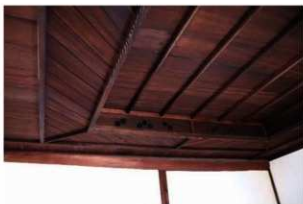
本館3階の階段天井
