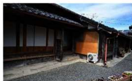
主屋東面外観
