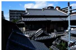
主屋南面外観
