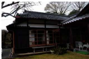
主屋 東面外観
