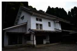
主屋東面外観
