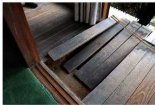
式台(取り外し可能な縁板を半ば外した状態)
