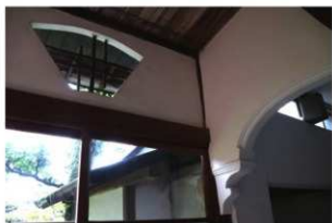
大広間棟1階の廊下
