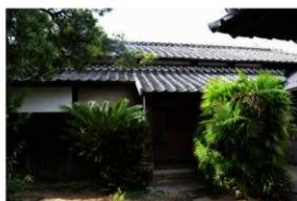
南面玄関廻り外観
