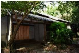
東面玄関廻り外観
