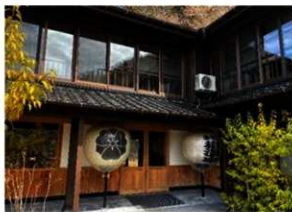
玄関廻り外観
