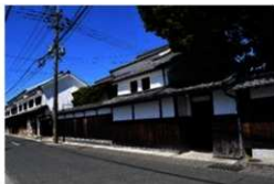
主屋南面外観
