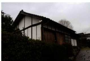
漬物小屋・風呂場 東面外観、石畳アプローチ
