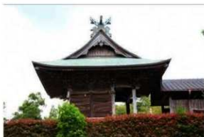
本殿・幣殿側面
