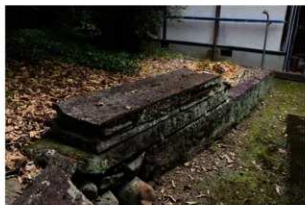
解体された小屋の屋根を葺いていた板石
