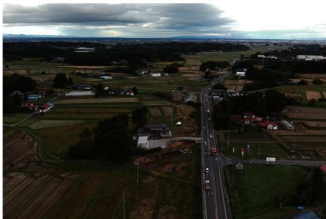
1. 彦右工門橋梁跡、吹付梁跡、吹付C梁跡 全景 (南から)
