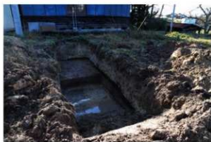
3. 1区 T10 トレンチ (北東から)
