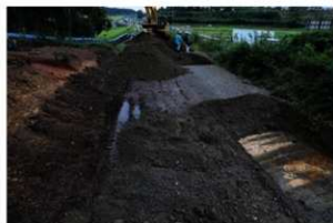
3. 仮設道路確認トレンチ（南西から）
