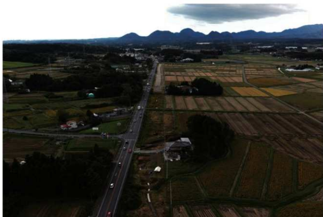
2. 彦右工門橋梁跡 全景 (北から)
