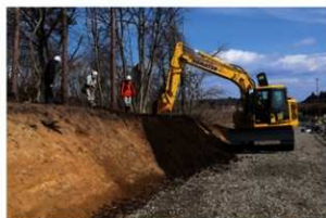
5. 表土掘削（南から）
