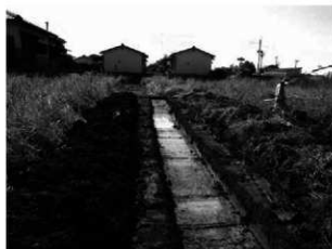
9トレンチ調査状況 (東から)
