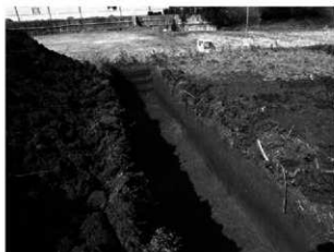
3トレンチ調査状況（東から）
