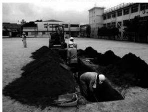
写真2 確認調査状況
