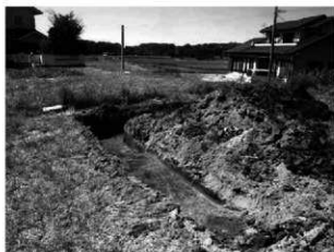
6 トレンチ調査状況 (東から)
