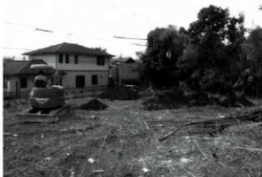
写真36 岩崎原遺跡調査状況
