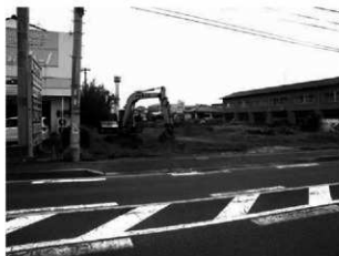
確認調査状況 (北から)
