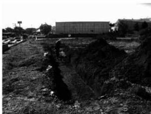
5トレンチ調査状況（東から）
