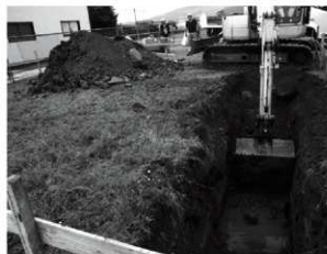
写真 29 九番開堤防確認調査状況 (西から)
