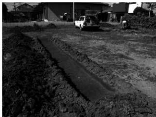
5mトレンチ調査状況(西から)
