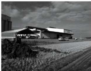
写真45 旧菊池川堤防調査地点 (東から)
