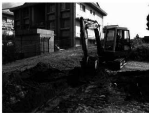
重機掘削状況 (北から)
