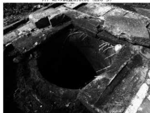
井戸跡の解体状況
