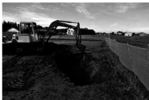
トレンチ掘削状況 (西から)
