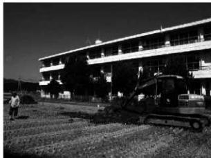
重機掘削状況 (南から)
