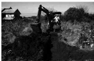
重機掘削状況 (南から)
