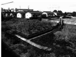
写真1 トレンチ掘削状況
