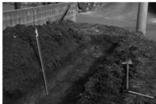
写真24 2トレンチ掘削状況 (南東から)
