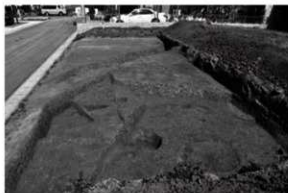
写真 26 東区完掘状況（南から）
