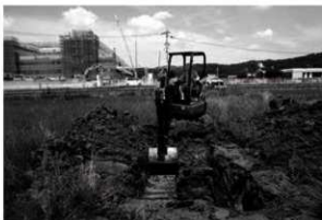
写真1 トレンチ掘削状況
