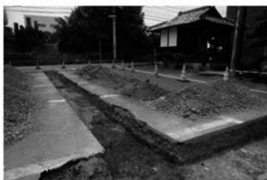
写真7 繁根木遺跡群1区9トレンチ掘削状況（南東から）
