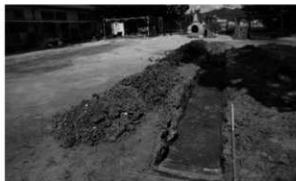
写真8 繁根木遺跡群2区2トレンチ掘削状況（西から）
