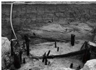
玉名平野遺跡群2区-1 N-9木橋埋没状況(土層) 北西より
