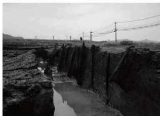
玉名平野遺跡群 1区-2 SA08 杭列検出状況 (1) 北西より
