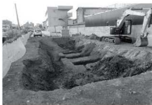
A区 全景 南東から
