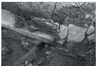
C区 地下室 側板-石積取り付け状況 南東から
