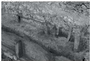
C区 地下室 杭列 南東から
