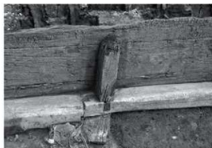
C区 地下室 立角材 南西から
