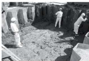
A区 下水道に連立杭立会状況 北西から
