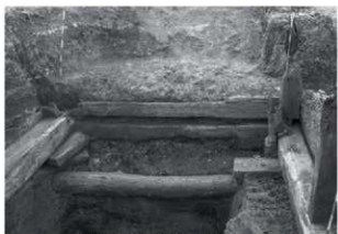
C区 地下室 西側板 東から
