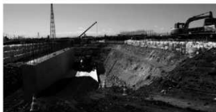
写真12 上武道路と交差する細ヶ沢川右岸護岸断面
