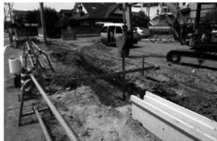
写真21 六供町の道路工事現場
