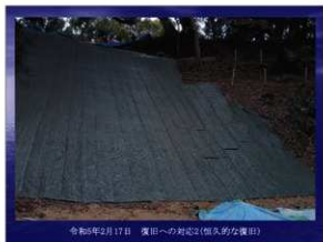
令和5年2月17日 復旧への対応②(恒久的な復旧)
