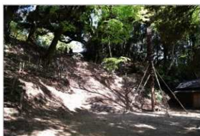
松庭復旧状況と松柱（令和5年4月9日）
