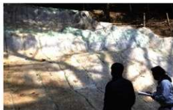
令和4年3月復旧への対応1(南東より)
