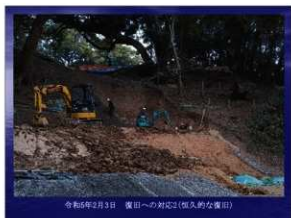
令和5年2月3日 復旧への対応②(恒久的な復旧)
