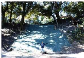
令和5年2月復旧への対応2(東より)
