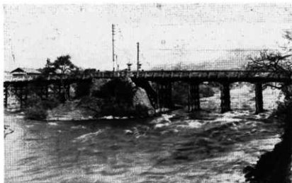
夕顔瀬橋 〔明治末古写真〕 材木町側から上流方向を望む
