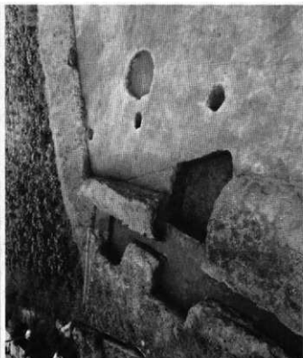
4. 12号独立柱建物(南から)
