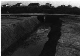
第 75 図 3号溝完掘状況 (北西から)
