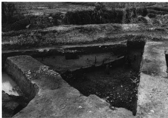
(2) 橋脚 (南東から、左畔上の小碑は道路状遺構)
