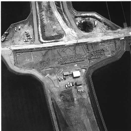
1 1区東端部全景 (空中写真)
