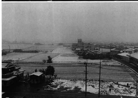
3 浮羽バイパス路線 (西から)
