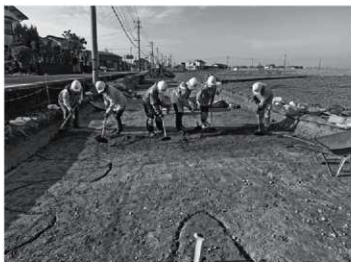
遺構検出作業
