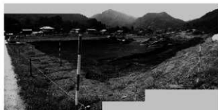
写真6 大割目周辺(2005年9月) 造成工事には天明泥流堆積物が確認できた。
