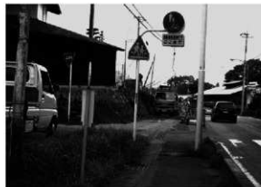
写真9 松谷の国道脇歩道工事の断面(2008年8月) 掘削断面には天明泥流堆積物は確認できない。
