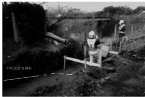
写真23 松見橋左岸側工事 1m程度の天明泥流堆積物が確認できた(2009年3月)。
