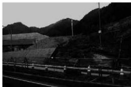
写真8 周辺工事の露頭(2015年9月) ここでは天明泥流堆積物は確認できない。
