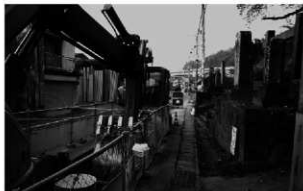
写真15 善導寺門前供養塔 下水道敷設工事では、僅か数10cmの深さで天明泥流堆積物が確認できた(平成20年(2008)10月)。
