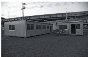
プレハブ設置状況
