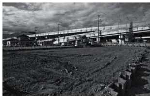
A区 着手前状況
