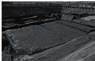
調査区完掘状況
