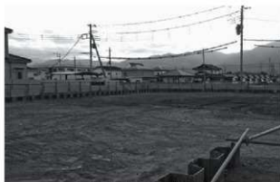
A・B区 埋め戻し完了状況
