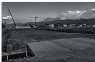
B区 埋め戻し完了状況
