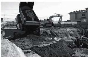
A区 埋め戻し状況
