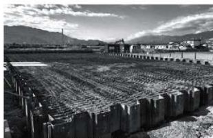
A区 埋め戻し完了状況
