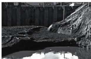
SD2 完掘状況
