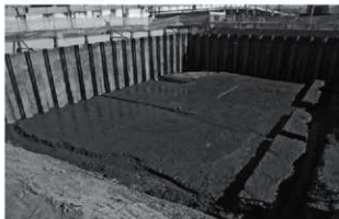
調査区完掘状況
