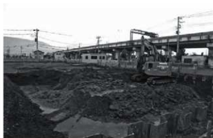
A区 表土はぎ状況
