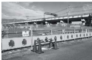
調査区養生状況
