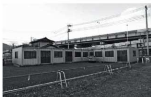
プレハブ設置状況
