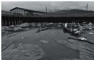
○現場が水没している様子（第5次）
