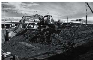
A区 表土はぎ状況
