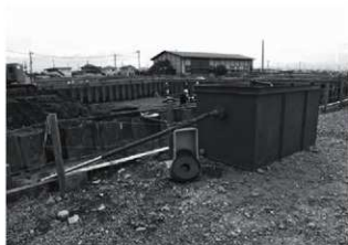
ろ過タンクを用いて排水している様子(第5次調査)
