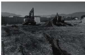
重機による表土掘削作業
