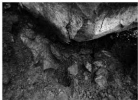
岩盤検出状況
