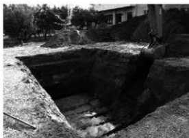
新4a地点トレンチ完掘状況
