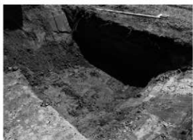
新1bトレンチ完掘状況
