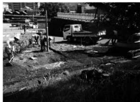
土壌のすき取り作業状況
