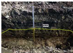
No.14 10T御蔵道断面確認状況
