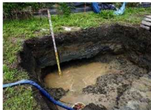
No.2-南-1 トレンチ全景
