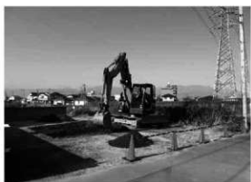
新4c 地点掘削状況
