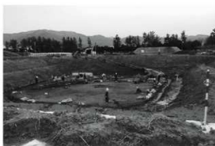
人力掘削状況
