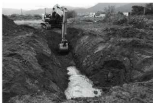
範囲確認調査 掘削状況
