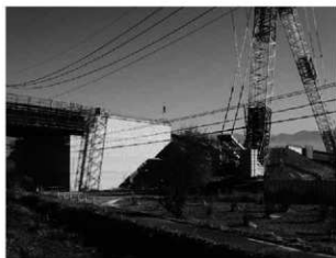
調査後の施工状況（令和6年1月 南西から）
