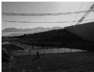
調査後の施工状況（令和6年1月 北西から）
