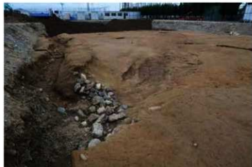
水路を壊す氾濫の痕跡
