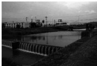
三番堰用水(君川用水)取水堰(北東から)
