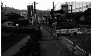
写真10 国道17号添いの下水管敷設工事(2012年12月) 写真の工事地点には天明泥流堆積物が認められたが、写真手前の工事地点では天明泥流堆積物は認められなかった。
