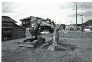
埋め戻し状況
