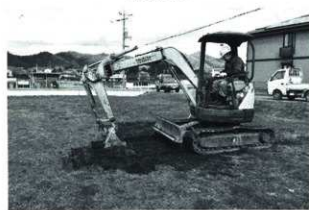
埋め戻し状況
