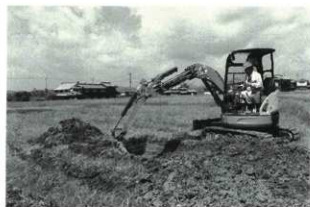
埋め戻し状況
