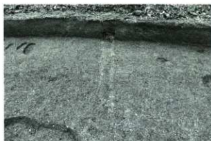
暗渠状況（南から）
