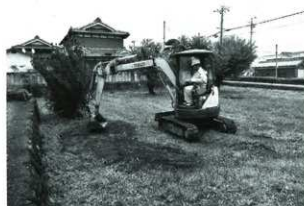
埋め戻し状況
