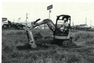
埋め戻し状況
