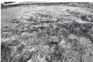
埋め戻し後状況
