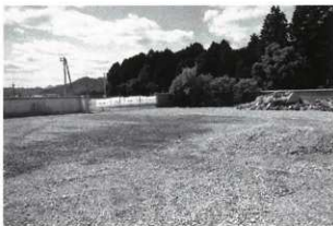
埋め戻し後状況
