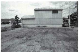
埋め戻し後状況
