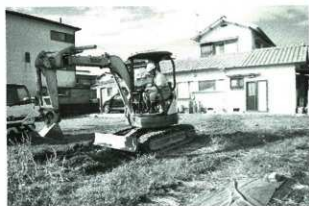
埋め戻し状況
