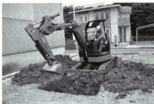
埋め戻し状況
