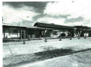
埋め戻し後状況
