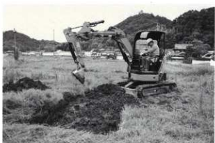
埋め戻し状況
