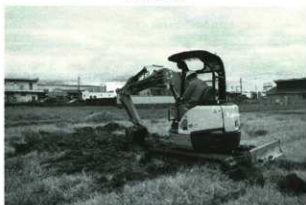
埋め戻し状況
