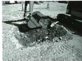
G19機械掘削
