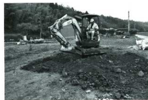
埋め戻し状況
