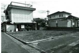
調査地点全景 (北西から)
