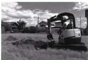
埋め戻し状況
