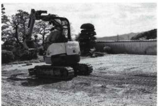
埋め戻し状況
