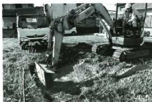
G1掘削状況
