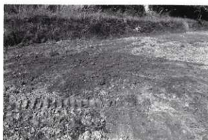
埋め戻し後状況
