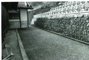
調査地点全景(北から)
