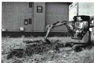
埋め戻し状況
