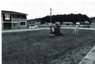
調査地点全景 (南東から)
