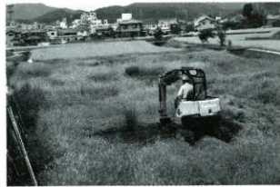
埋め戻し状況
