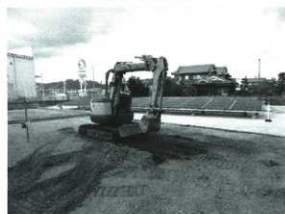
埋め戻し作業
