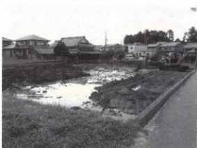
埋め戻し後の状況
