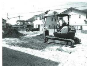
埋め戻し状況
