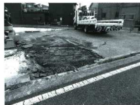
坪19 埋め戻し後の状況
