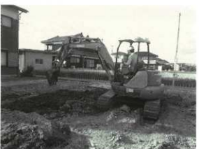
埋め戻し作業
