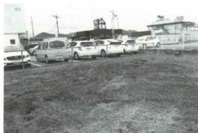
埋め戻し後の状況
