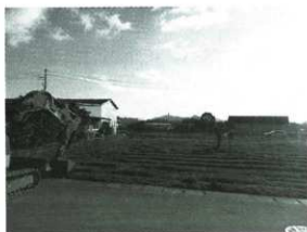
調査前の状況 (西から)
