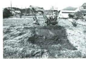
埋め戻し作業
