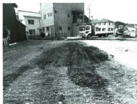
坪18 埋め戻し後の状況
