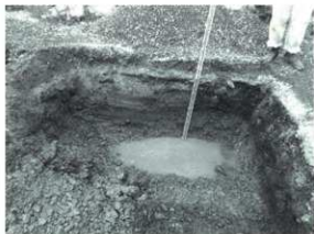
坪16 断ち割り状況
