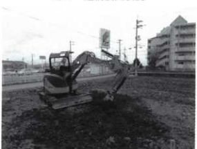
埋め戻し作業
