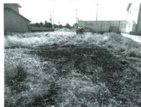
埋め戻し後の状況
