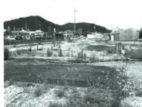
坪3 埋め戻し後の状況
