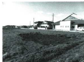
埋め戻し後の状況
