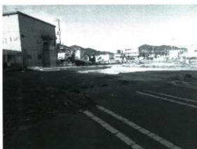
坪18 調査前の状況（北西から）
