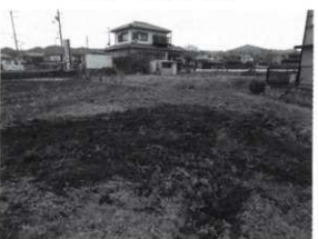
埋め戻し後の状況
