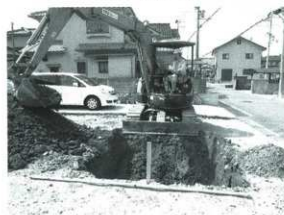
埋め戻し状況
