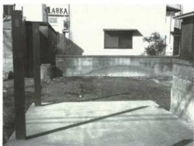
埋め戻し後状況
