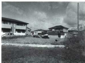
調査前の状況
