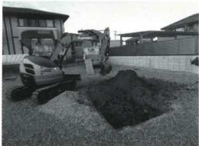
埋め戻し作業
