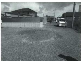
埋め戻し後の状況
