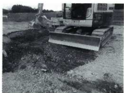
埋め戻し作業
