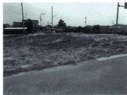
埋め戻し後の状況
