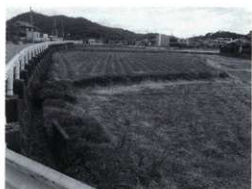
調査前の状況
