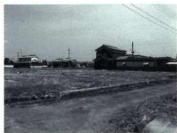
埋め戻し後の状況
