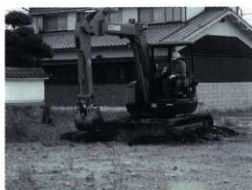
埋め戻し作業
