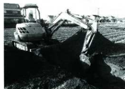
埋め戻し作業
