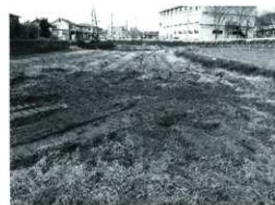
埋め戻し後の状況
