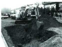
埋め戻し作業
