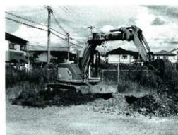
埋め戻し作業
