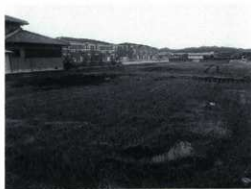
埋め戻し後の状況
