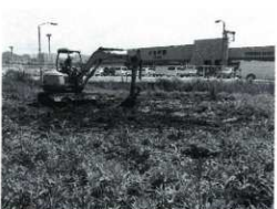
埋め戻し作業
