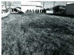
埋め戻し後の状況
