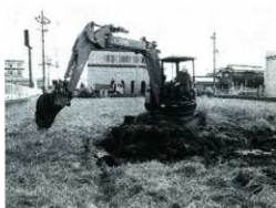
埋め戻し作業
