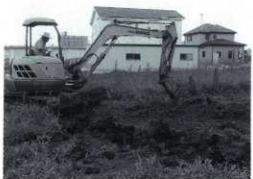
埋め戻し作業
