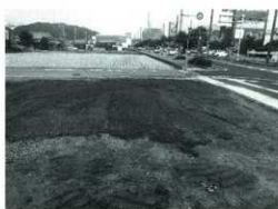
埋め戻し後の状況
