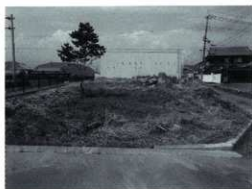
埋め戻し後の状況
