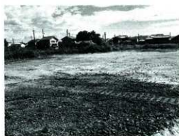
埋め戻し後の状況
