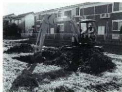
埋め戻し作業
