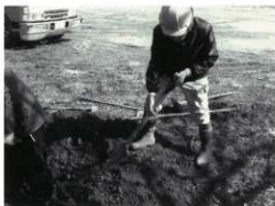
トレンチ2埋め戻し作業
