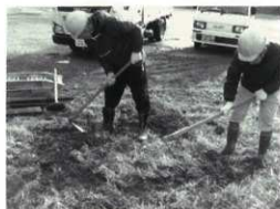
手掘り掘削作業
