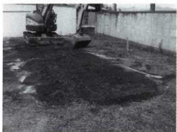
重機埋め戻し作業
