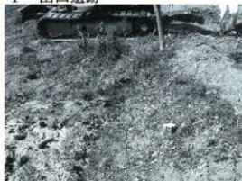
調査前の状況
