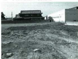
調査前の状況
