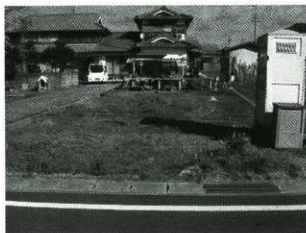
写真3 調査前の状況
