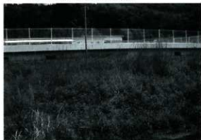
調査前の状況
