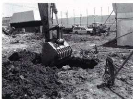
調査区2掘削状況
