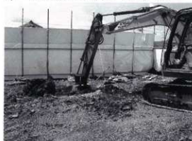
調査区1掘削状況
