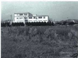
調査前の状況
