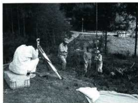
測量作業風景
