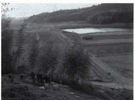
調査区からの遠景
