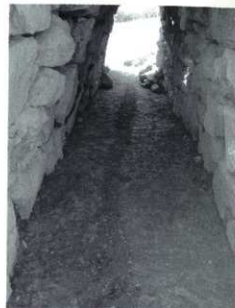
排水溝検出状況（東から）
