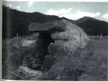
復元作業（南西から）
