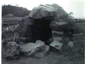
復元作業（北東から）
