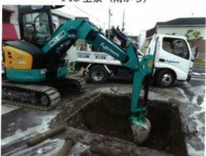
15G 機械掘削
