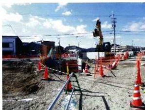
駅前東側（工事立会）
