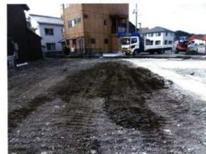
18G 埋め戻し終了(北から)
