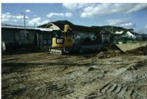
調査区西側埋め戻し状況
