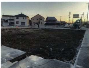
調査前（改良土除去後・南西から）
