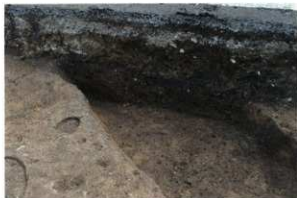
SX02 断面 (南から)
