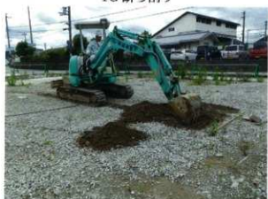
2G 機械掘削
