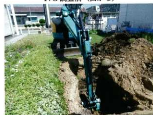
17-1G 機械掘削
