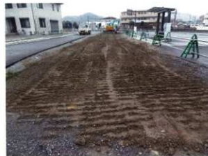
埋め戻し終了後（北から）
