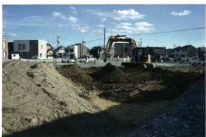
調査区西側埋め戻し状況
