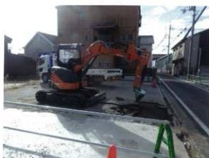
19G 機械掘削
