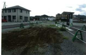
13G 埋め戻し終了 (北から)
