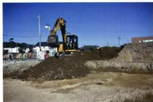
調査区東側埋め戻し状況
