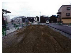
埋め戻し終了後（南から）
