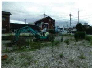
1G 機械掘削
