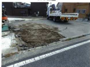
19G 埋め戻し終了 (南東から)
