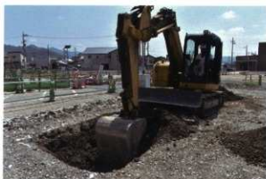
重機掘削状況
