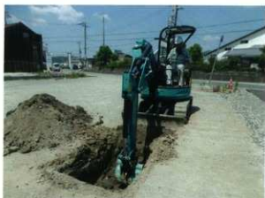
5G 機械掘削
