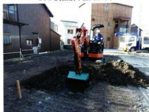
18G 機械掘削
