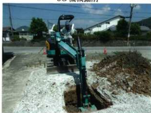
6G 機械掘削
