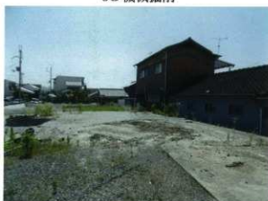
6G 埋め戻し終了 (南から)
