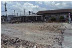
調査前（東から）
