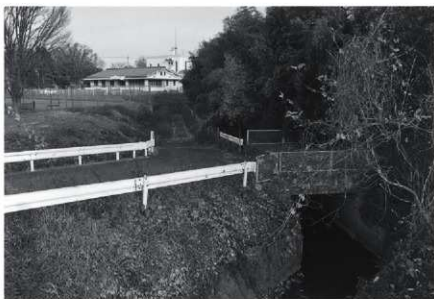
写真3 粕川右岸の深い堀
