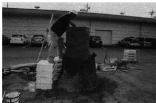
写真15 上窯の構築
