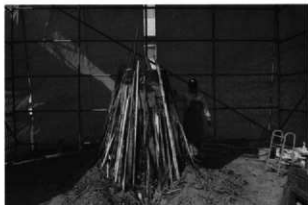
写真38 上窓構築後の強制乾燥
