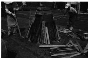
写真14 中窯の強制乾燥
