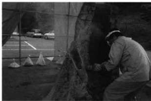
写真47 グラインダーを使用した群埋文3号炉の解体
