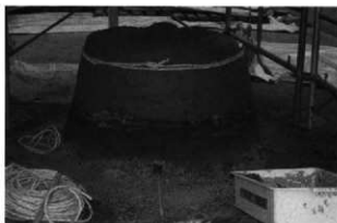
写真13 荒縄を巻き付けて補強 荒縄を巻き付けて、乾燥前の炉が広がらないように補強した。後日、新見市の製鉄実験を見学した際、荒縄を粘土汁に浸してから使用していた。粘土汁に浸してから荒縄を巻いた方が、より炉をしっかりと補強できる。
