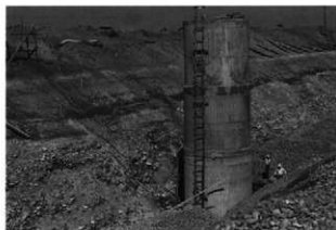
写真12 三和工業団地I遺跡の北に隣接する書上水場建設当時の写真（昭和46年） ローム層の下に大間々層状地の礫層が厚く堆積する （星野正明氏撮影）
