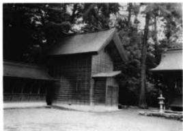
写真1 平成4年式年遷宮仮殿
