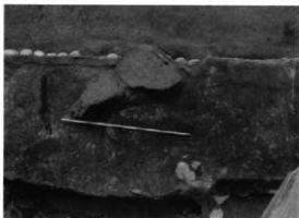
写真13 建物南側の根太痕と倒れこんだ壁
