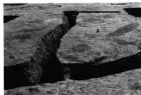
④周溝からの排水溝に竪穴部からの排水溝の連結
