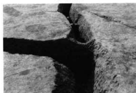
③排水溝の陸橋
