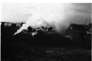
⑧ 崩落の途中（棟の崩落段階）
