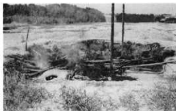
⑦ 47:00経過 南側の柱2本転倒（東より）
