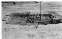
⑬ 鎮火後、葺き材撤去後の状況（南より）
