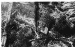
⑪ 13:00～19:00経過 柱下部の燃焼状況（南より）
