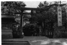
写真1 大鳥居より二王門を望む 南→
