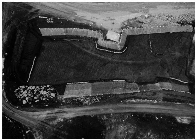
5 D3区1面全景(南東から)
